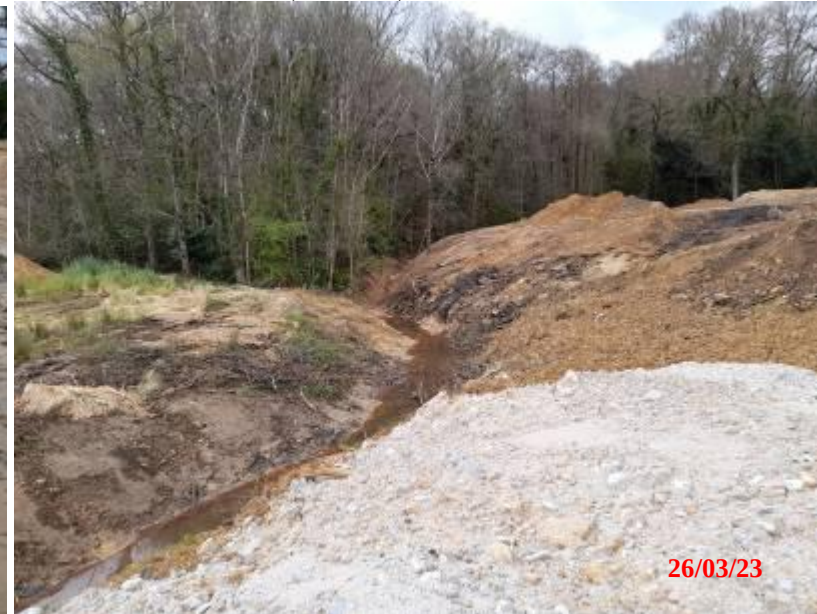
Photo 11 origine du filet: fossé creusé à la pelle mécanique.
