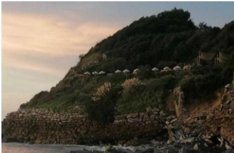
Installé sur un site offrant une vue à couper le souffle, le Camping Playa aurait commis des infractions au code de l'urbanisme. WAGNIER DÉPÔTÉ
