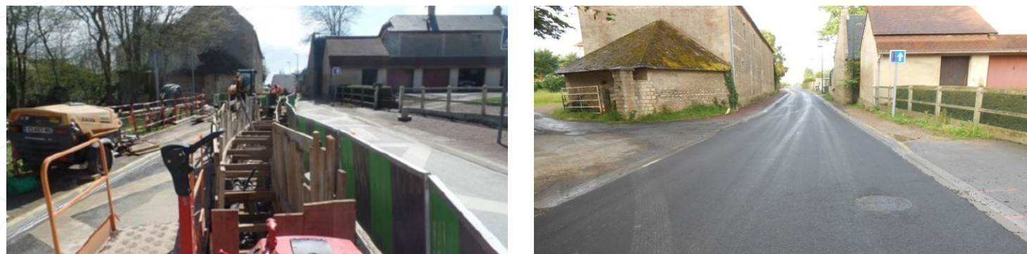
Exemple d'un chantier de liaison électrique souterraine PENDANT et APRES travaux (IFA2, Calvados)
