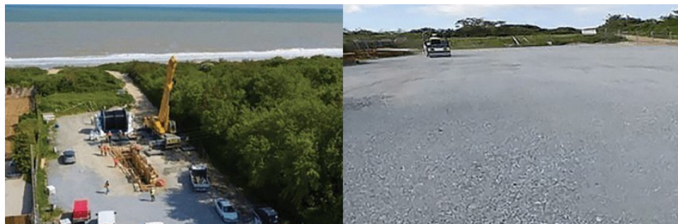
Exemple d'un chantier d'atterrage PENDANT et APRES travaux (Atterrage IFA2, Calvados)
