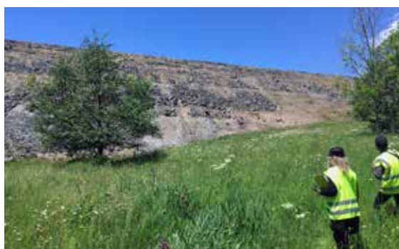
Digue de la retenue, ancienne mine des Bois noirs
