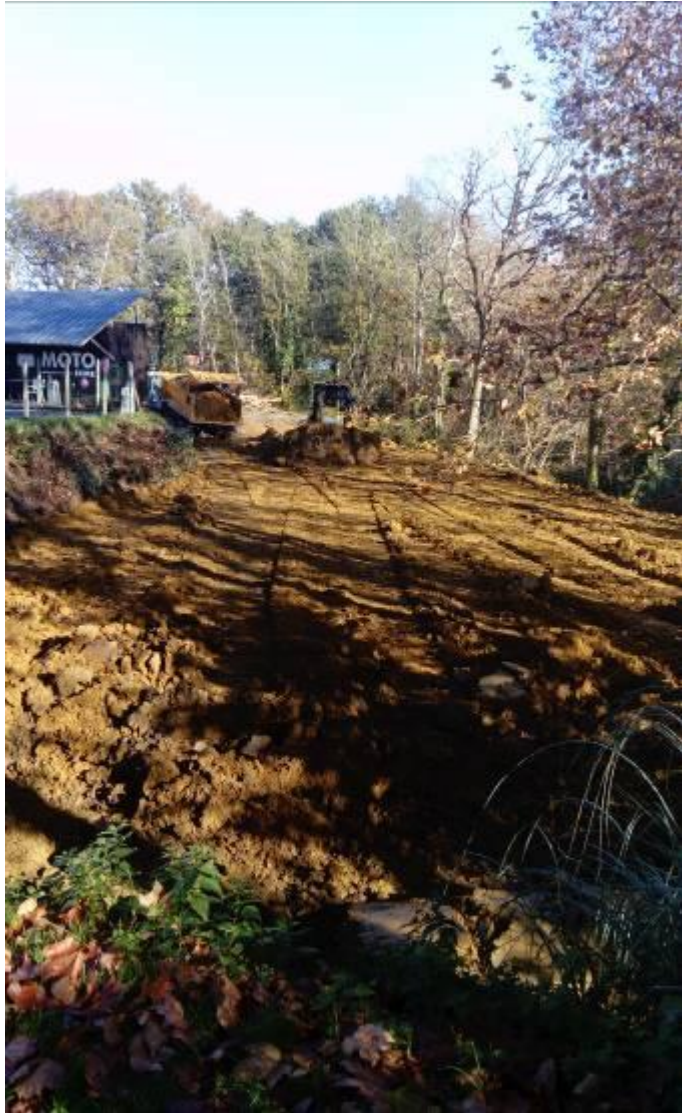
Remblaiement sur la parcelle 116
