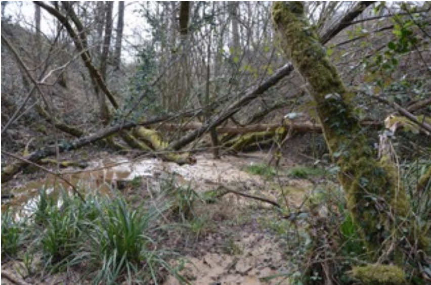
Glissement de terrain
