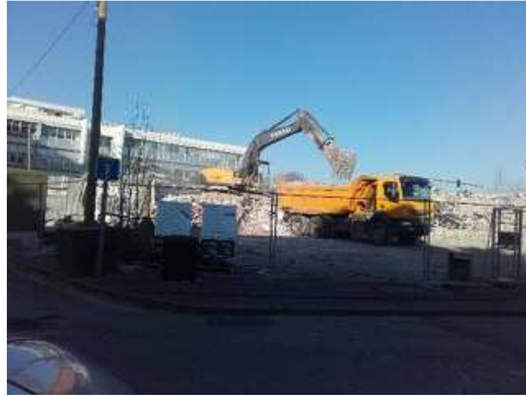
Chargement du camion de déchets. Les gravats viennent d'Anglet, de la démolition du bâtiment Culturel Leclerc sur l'ancienne RN10 à Anglet Bernain.
