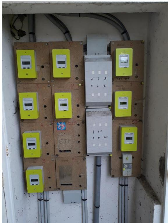
Dans l'armoire on enregistre les mêmes pics d'émission qu'à l'abord du transformateur, mais on ne mesure pas de champ électrique significatif (bonne protection des boîtiers des compteurs ??).
