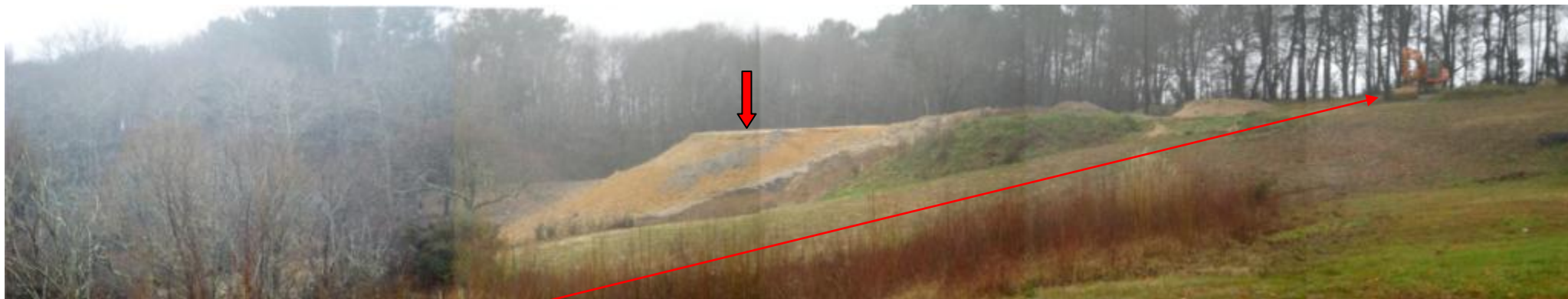
Panoramique du nouveau chantier le 11 février 2018:
