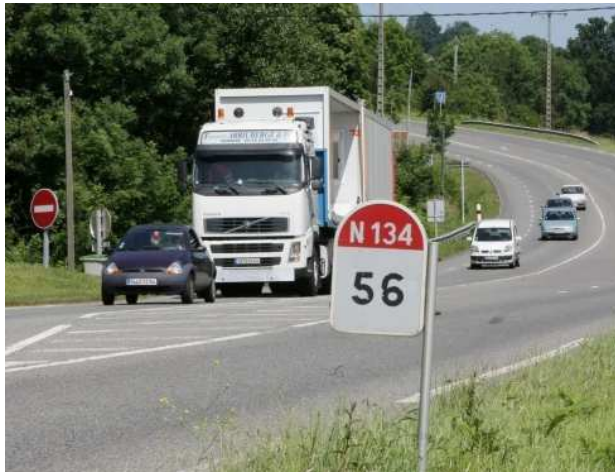
Code Béarn espère toujours des travaux de sécurisation de la RN 134. (J.-P. G.)
