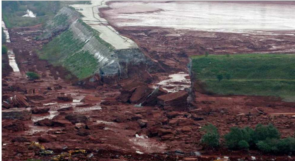
Figure 22 : Rupture de digue (Hongrie, 2010)
