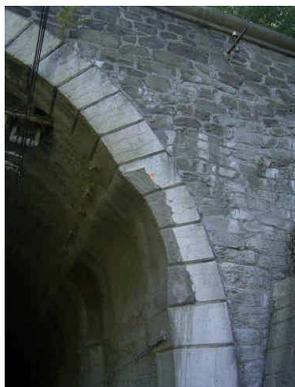
**Figure 1 : exemple de travaux de rescindement : cas d'un voussoir en béton projeté**
