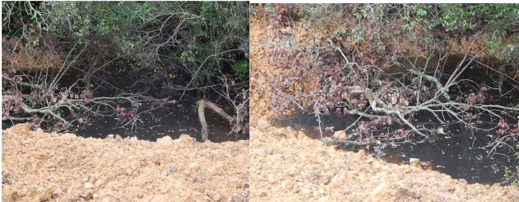
Ruisseau recouvert et barrage
