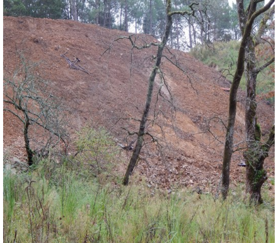
Arbres morts en pied de talus
