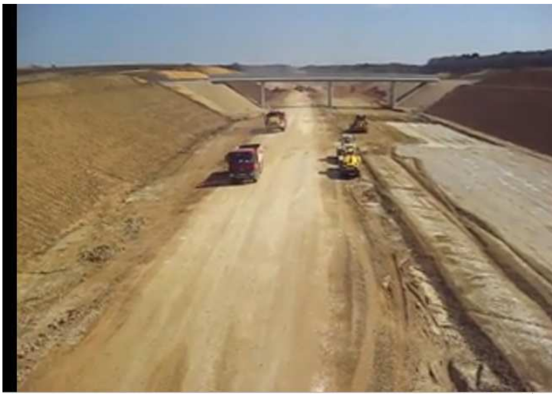
Photo prise sur le chantier de construction de la LGV Rhin Rhône
