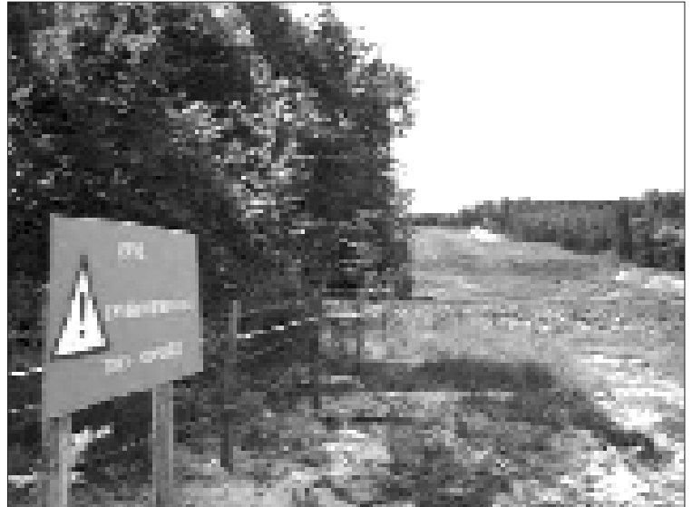
Chantier de l'autoroute A28 en Forêt de Bercé Site NATURA 2000 (Juin 2004)
